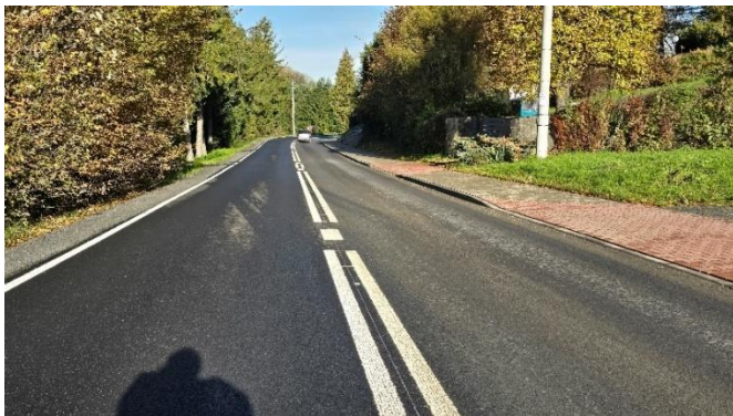
Zdjęcie 27 Droga 1707K Brody-Palcza przebudowana przy udziale środków z "Polskiego Ładu"
