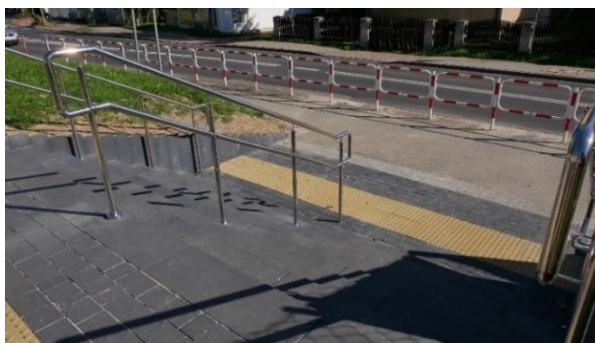
Zdjęcie 40 Wyremontowane schody wejściowe do CKZiU Nr 1 w Wadowicach
