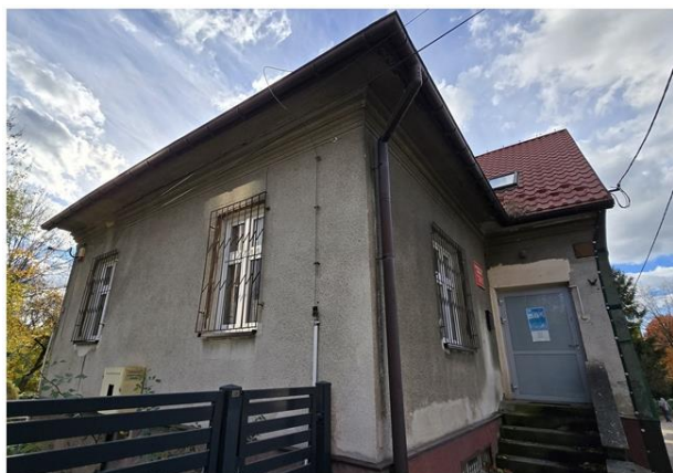
Zdjęcie 4 Budynek andrychowskiej filii ŚDS, który będzie poddany termomodernizacji
