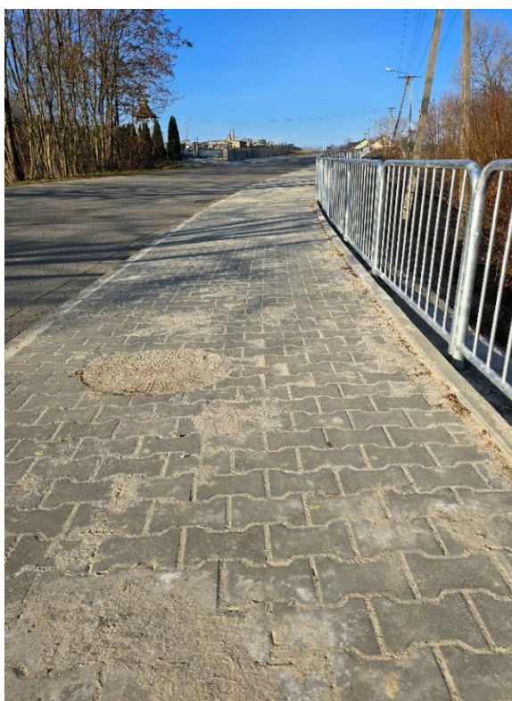
Zdjęcie 35 Nowy chodnik przy drodze powiatowej 1765K w Radoczy
