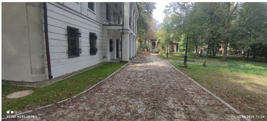
Zdjęcie 22 Wykonane prace renowacyjne przy dworku Emila Zegadłowicza w Gorzeniu Górnym
