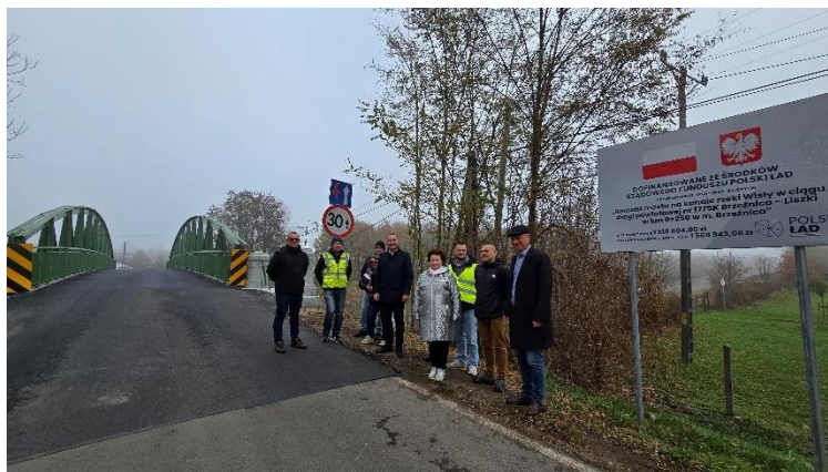
Zdjęcie 26 Nowy most w Brzeźnicy
