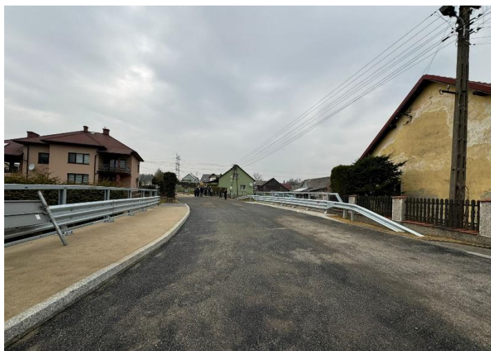
Zdjęcie 27 Nowy most w Bachowicach
