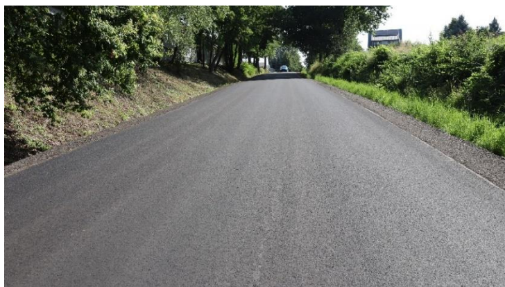
Zdjęcie 34 Wyremontowana droga powiatowa 1799K w Kleczy Dolnej
