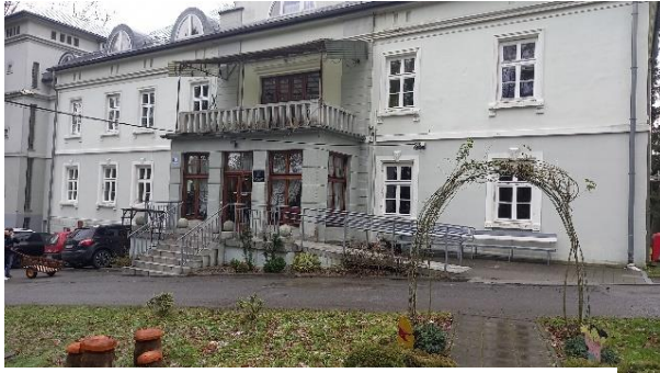
Rys. 3 Nowe okna w budynku Dworek, wchodzącym w skład DPS w Izdebniku.
