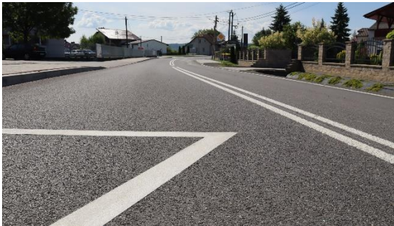
Rys. 31 Droga powiatowa 1782K po przebudowie.
