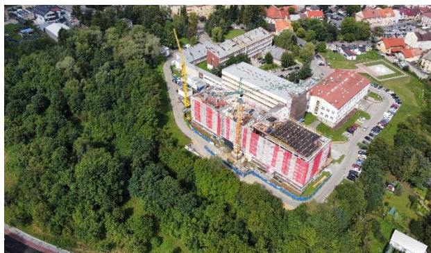
Rys. 40 Nadbudowa Szpitala Powiatowego w Wadowicach o dwie kondygnacje - widok z "lotu ptaka".
