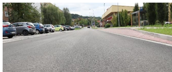
Rys. 24 Przebudowana droga 1754K - ul. Lenartowicza w Andrychowie.
