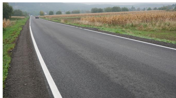
Rys. 32 Wyremontowany odcinek drogi powiatowej 1772K w Łączanach.
