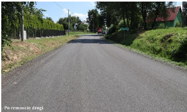
Rys. 25 Wyremontowany odcinek drogi 1764K we Frydrychowicach.
