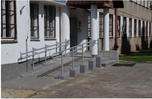
Rys. 37 Podjazd dla wózków inwalidzkich przy budynku ZS im. KEN w Kalwarii Zebrzydowskiej.
