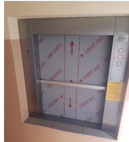
Rys. 2 Nowa winda towarowa w DPS przy ul. Pułaskiego w Wadowicach.
