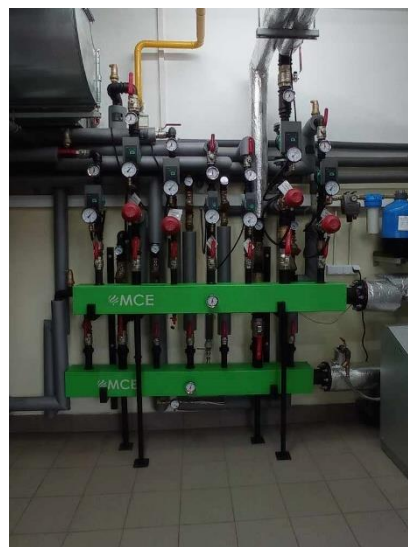
Rys. 35 Nowa instalacja c.o. w CKZiU Nr 1 w Wadowicach.
